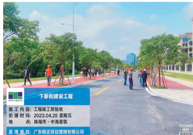
下新街建设工程 施工内容: 工程竣工验收 拍摄时间: 2023.04.28 星期五 地点: 珠海市·中海星筑 监理单位: 广东明正项目管理有限公司
